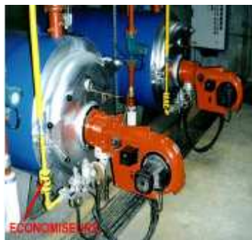
Economiseur de combustible installé sur une chaudière
